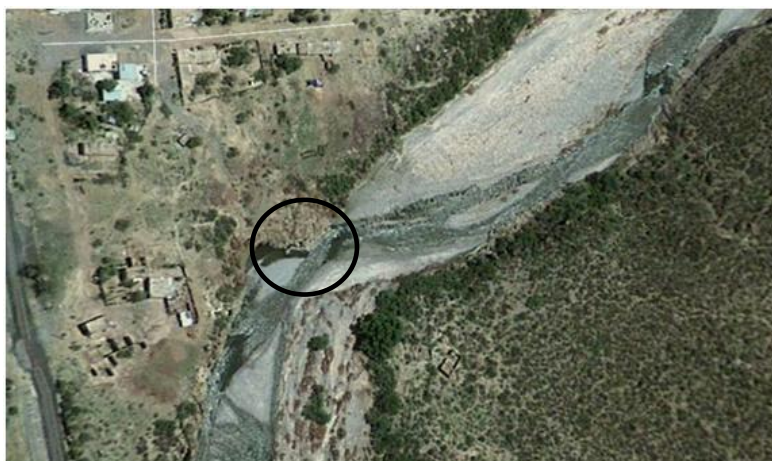
Foto 3.- Ubicación de una de las obras de toma (Altamira) del ejido Zertuche.
