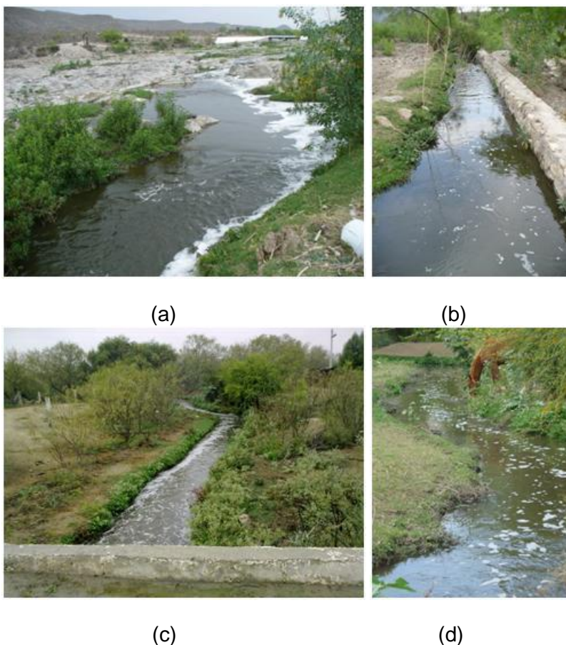
Fotos 4.- a) Punto del arroyo - en Zertuche- en el que se desvía el agua a la obra de derivación para el canal del arroyo Higo; b) obra de derivación (de mampostería por un lado, y de tierra por el otro y en el fondo; c) canal a la salida de la obra de derivación; d) caballo bebiendo directamente agua del canal de conducción.
