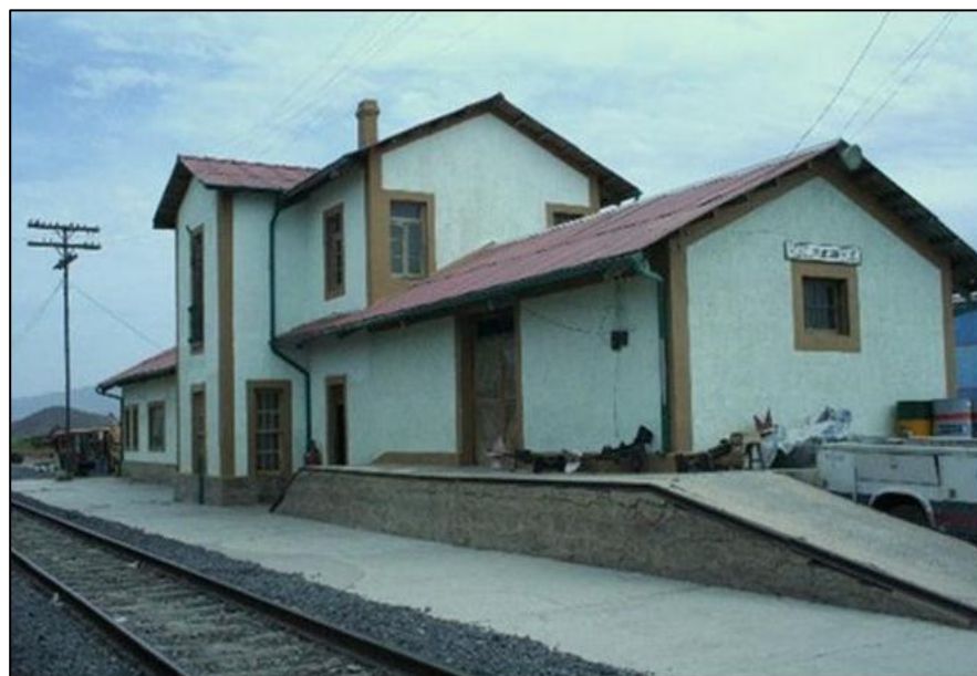
Foto 3.2.- Estación de tren en Paredón
